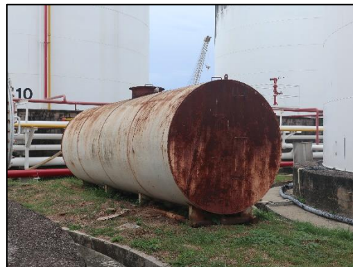
รูปที่ 2-10 ถังเก็บตะกอนขนาด 18,000 ลิตร
