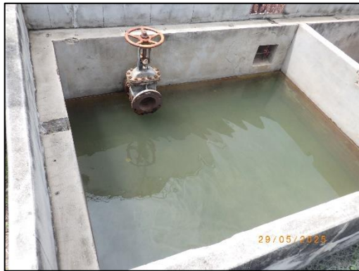
รูปที่ 2-27 บ่อบำบัด API ที่เก็บกักน้ำฝน ที่ตกบนท่าเทียบเรือ
