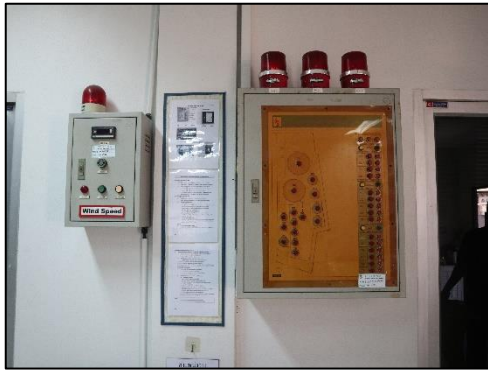
รูปที่ 2-19 ระบบเตือนภัยเมื่อมีความผิดปกติที่ถังเก็บกัก
