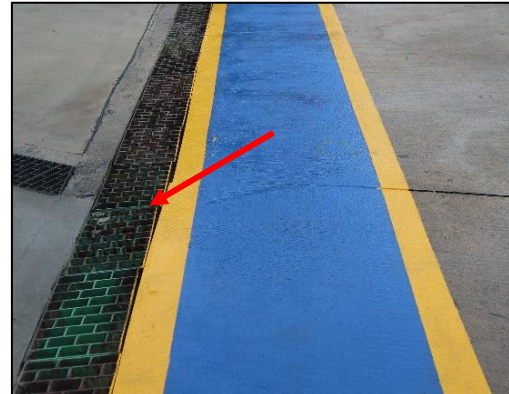
รูปที่ 2-8 ตะแกรงดักมูลฝอยบริเวณรางระบายน้ำฝน
