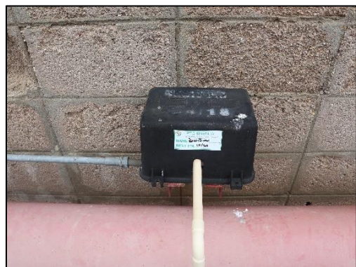
รูปที่ 2-11 ป้อนสำหรับต่อเครื่องเป่าอากาศในบ่อบำบัด เพิ่มอัตราการลอยตัวของอากาศ
